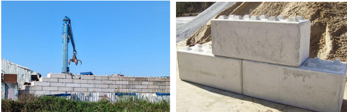
Abbildung 2: Verwendung von Schwergewichtsmauerwerk als Schüttgutsilowand (links), und als möglicher Geländesprung mit mehr als 1,0 m Höhe (rechts).
