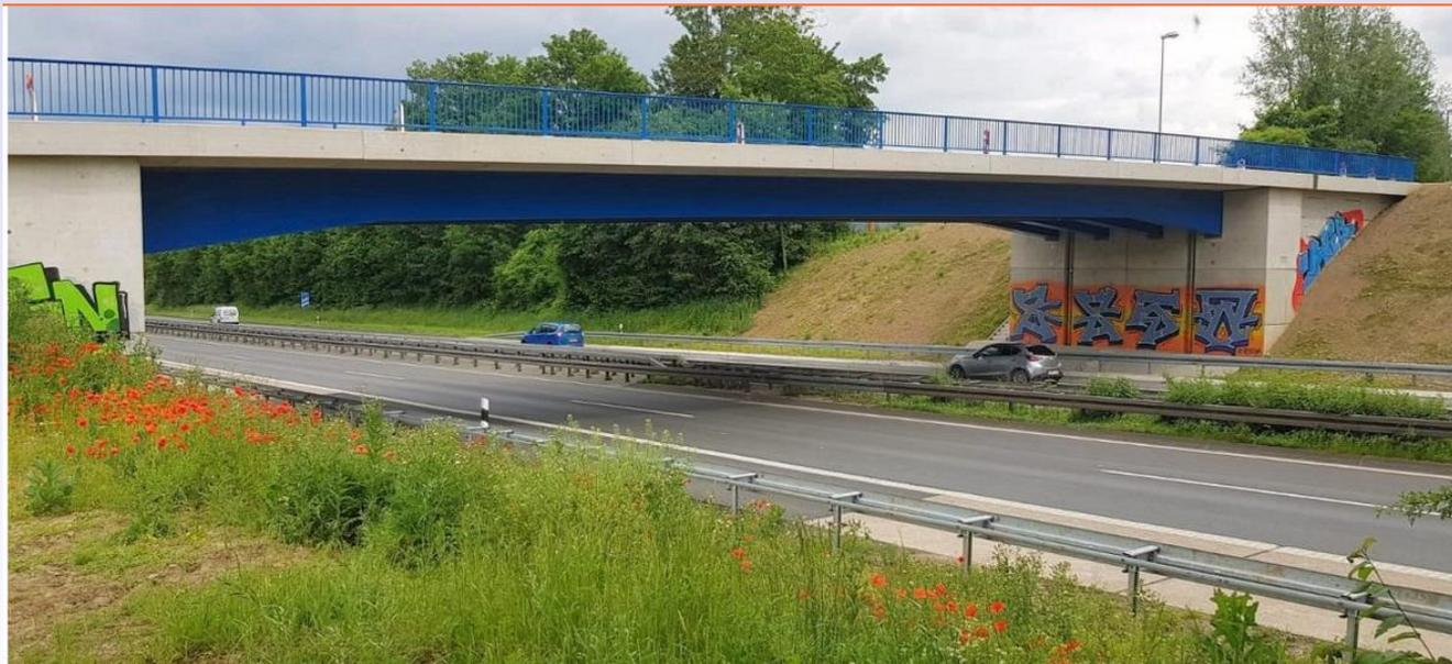
Die „Lego-Brücke“ an der A 46 in Hagen im Bereich Hammer. Aktuell laufen hier noch Arbeiten. Die Brücke in Fertigbauweise wird wohl die einzige ihrer Art bleiben.
