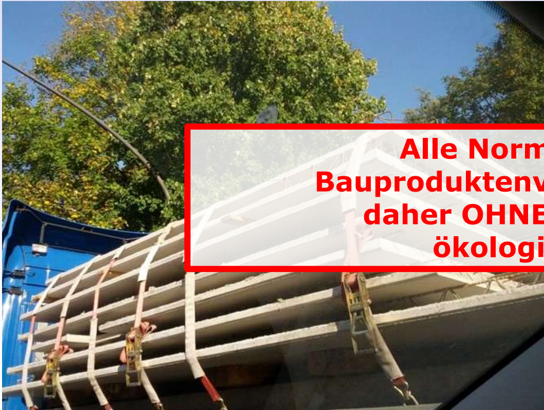
Deckenplatten mit Ortbetoneergänzung, EN 13747
